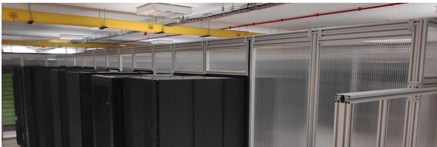
Adaptatif à toutes hauteurs de baies, baies libres de mouvement, appui limité sur les baies
